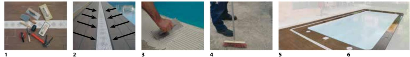
**1-** Resulta de gran importancia en la colocación la elección de las herramientas y útiles adecuados (llana dentada, maza de goma, crucetas para la colocación así como llana de goma y esponja con el fin de facilitar una operación de rejuntado adecuada).
