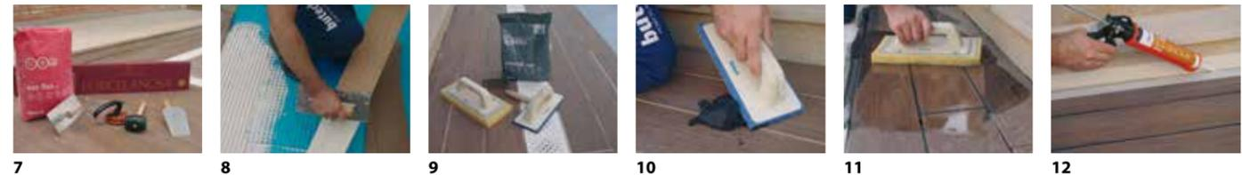
**7-** Los adhesivos a utilizar para colocar las baldosas cerámicas en exteriores serán siempre del tipo C2, según normativa EN 12004 (Adhesivos para baldosas cerámicas). Se deben respetar en cualquier caso las instrucciones de utilización del fabricante, lo que nos permitirá hacer un uso óptimo y obtener las máximas prestaciones del adhesivo.
